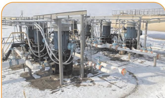
Рис. 1. Общий вид КНС СУ-10 ОАО «Самаранефтегаз»
