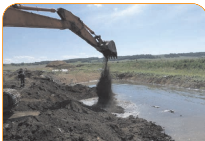
Рис. 4. Заполнение амбара смесью БШ, песка, фосфогипса и сорбента
