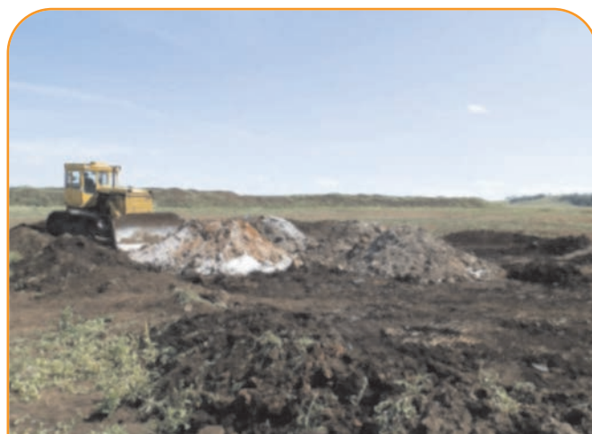
Рис. 2. Перемешивание БШ с песком, фосфогипсом и сорбентом
